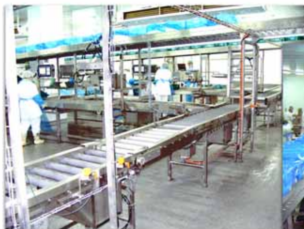
Fördertechnik mit Durchgang
