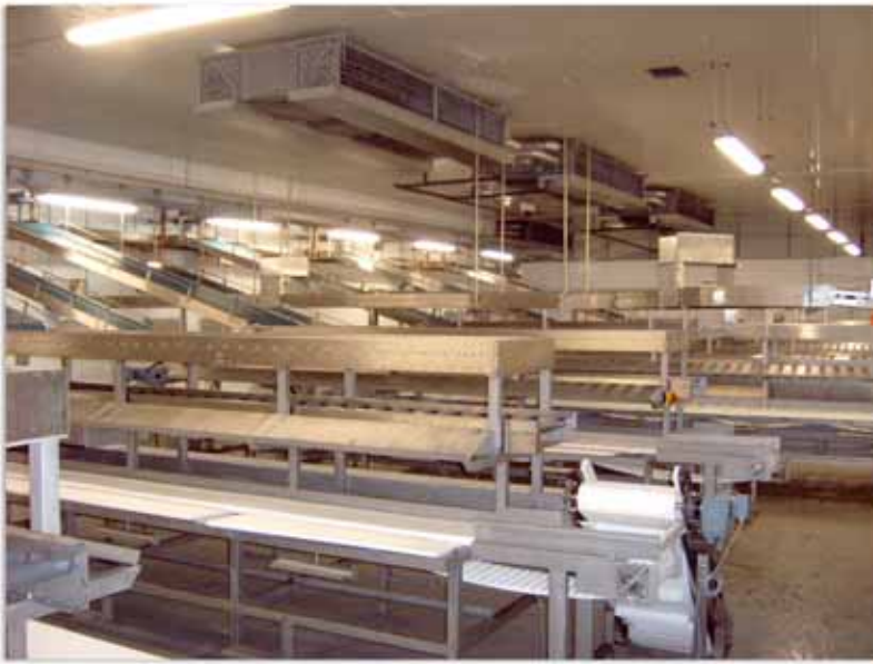
Aufbau einer Feinzerlegung
